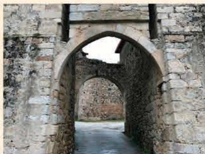
Porte de la forteresse, siège de la baronnie de Châteaumur.
